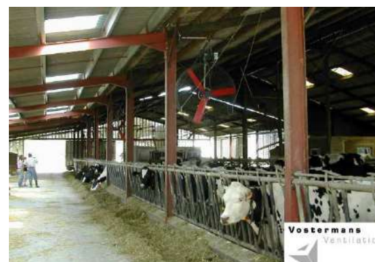
Brasseurs d'air en stabulation vaches laitières
