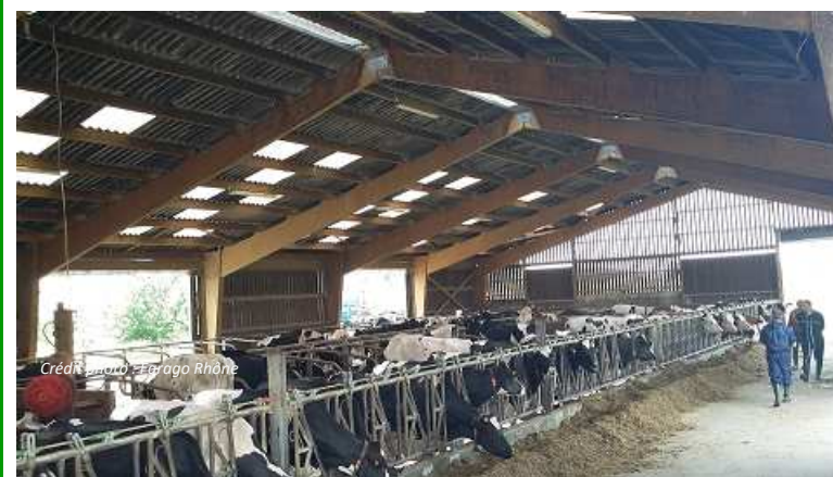
Ouvertures en long pan pour favoriser la ventilation latérale
