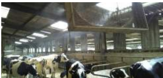
► Utilisation de brumisateurs en bâtiment
